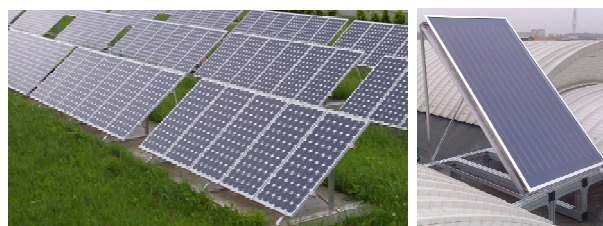
EXEMPLE DE PHOTO : PROFILÉS EN ALUMINIUM EXTRUDÉ POUR SYSTÈMES PHOTOVOLTAÏQUES / CALORIQUES
