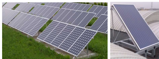
FOTO DI ESEMPIO: PROFILI ESTRUSI IN ALLUMINIO PER IMPIANTI FOTOVOLTAICI / CALORICI
